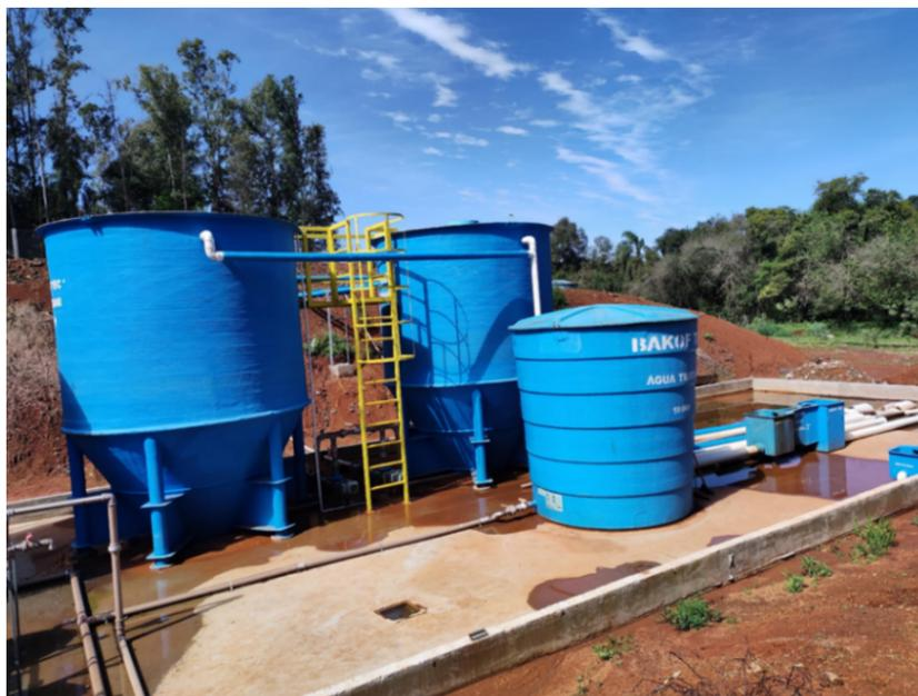
Figura 3. Reservatórios do sistema de reuso da água do frigorífico
